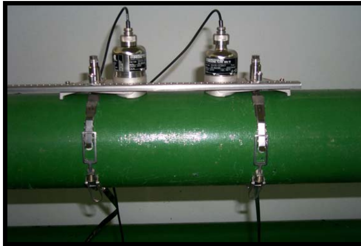
Figura 2.5 – Eletrodos do macromedidor do tipo ultra-som.
