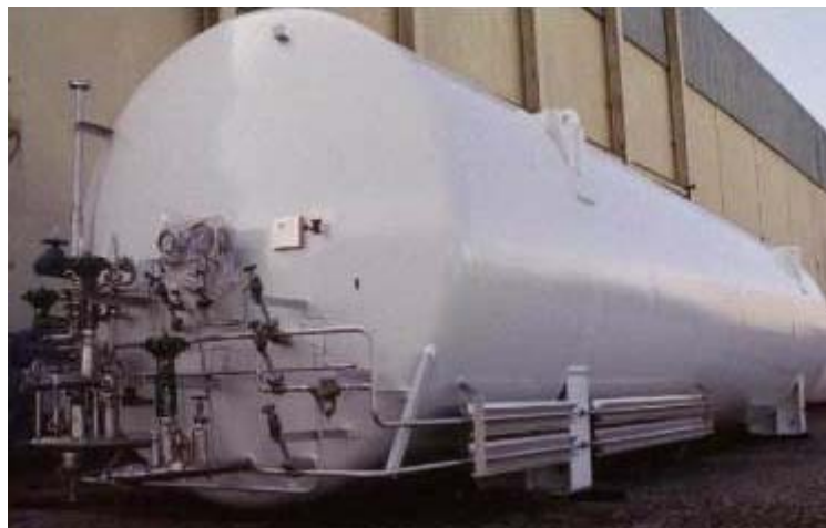
Figura 12: Tanque cilíndrico para armazenamento de hidrogênio líquido (CRYENCO, 2003)
